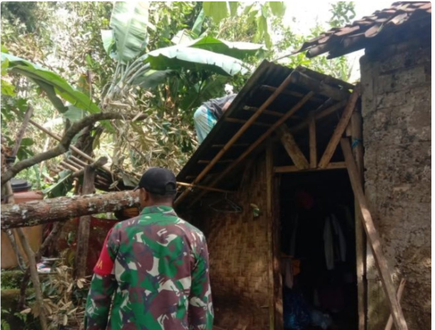
Koramil Cikidang Bantu Perbaiki Rumah Warga yang di Sapu Puting Beliung
