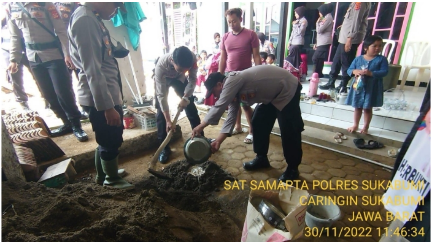
Kapolres Sukabumi Bantu Perbaiki Rumah Warga Yang Rusak Akibat Gempa
