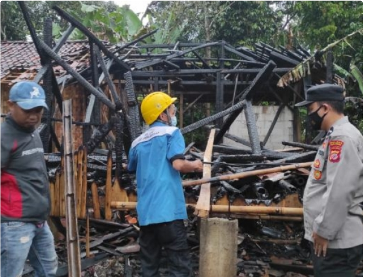
Diduga Akibat Konsleting Listrik Sebuah Pesantren Hangus Terbakar
